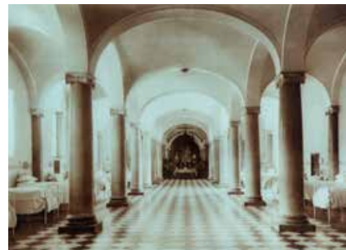
14 Cisterna del interior de la cuadra del Mal de Siment. Reconstrucción virtual. (Sección de Arqueología. Servicio de Patrimonio Histórico y Artístico. Ayuntamiento de València).
