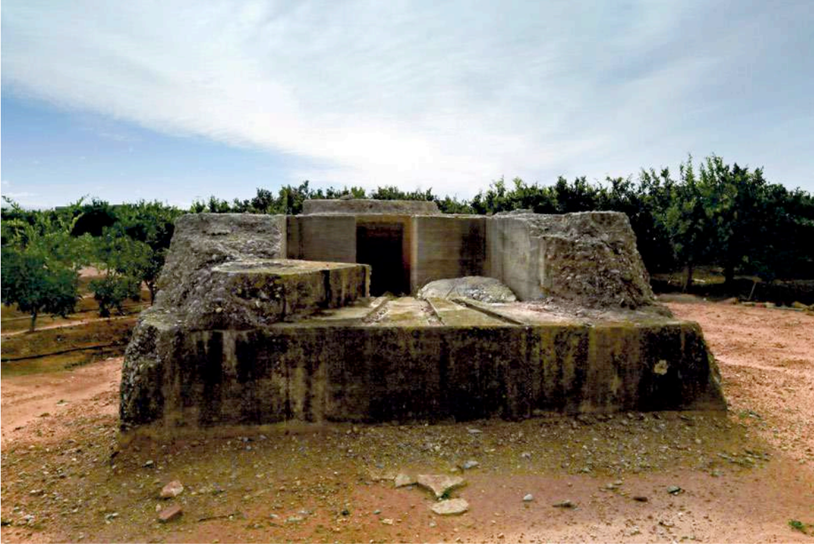
Fortí al Puig Fortín en El Puig
