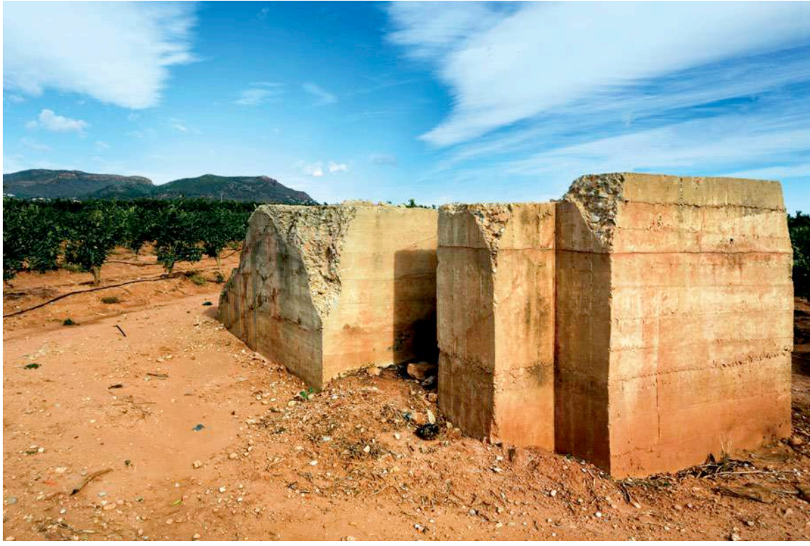
Restes d'un fortí al Puig Restos de un fortín en El Puig
