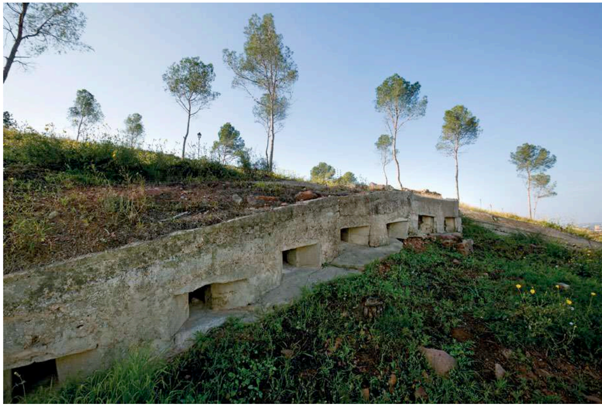
Casamata de fuselleria a la muntanya de la Pota del Puig Casamata de fuselleria en la muntanya de La Pata de El Puig
