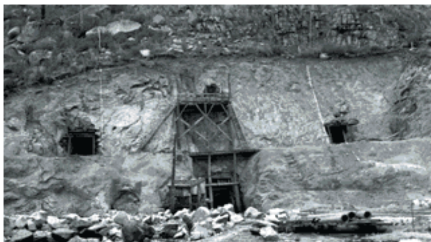
Obres de construcció de la cripta del Valle de los Caídos, 1950
